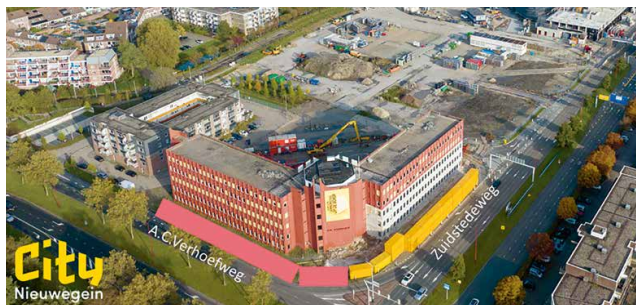
Rode gebouw aan de Zadelstede. Geel: zeecontainers die er al staan. Roer: plek waar extra zeecontainers 27 november geplaatst worden.
