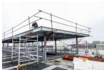
Foto boven: op het dak wordt een overkapping gebouwd over de hellingbanen
