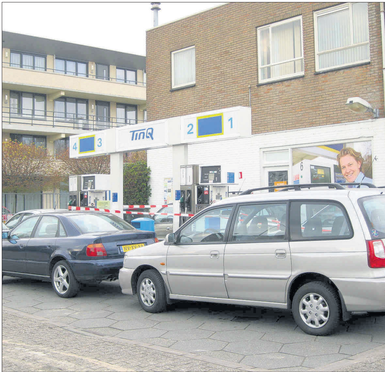
Het tankstation, in TinQ-kleuren, is gesloten voor de 15-jaarlijkse controle én om twee tanks te koppelen. Duidelijk zichtbaar de 'dove' gevel. (Foto: Grieta Felix)
