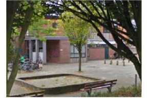
2. Flats Sluyterslaan groot onderhoud
