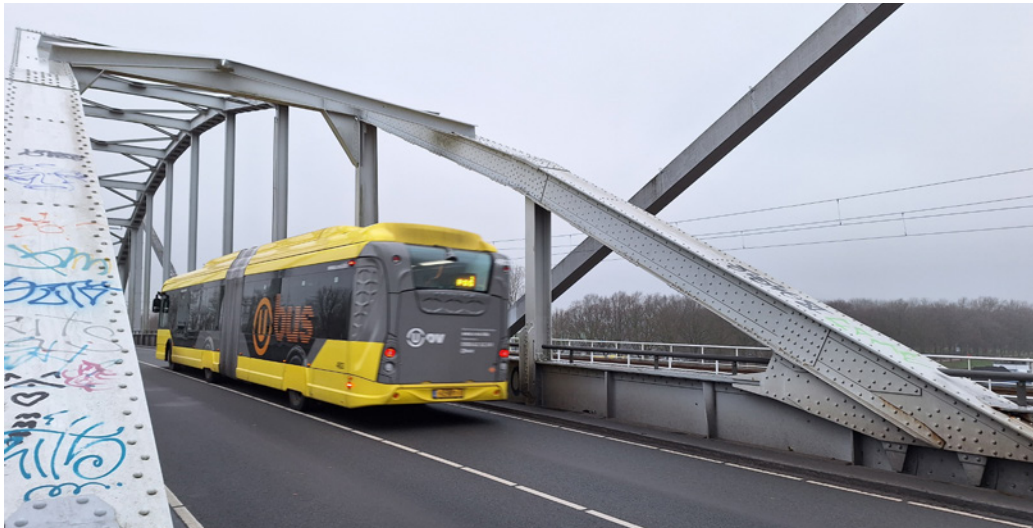
De bestaande Jutfasebrug over het Amsterdam-Rijnkanaal
